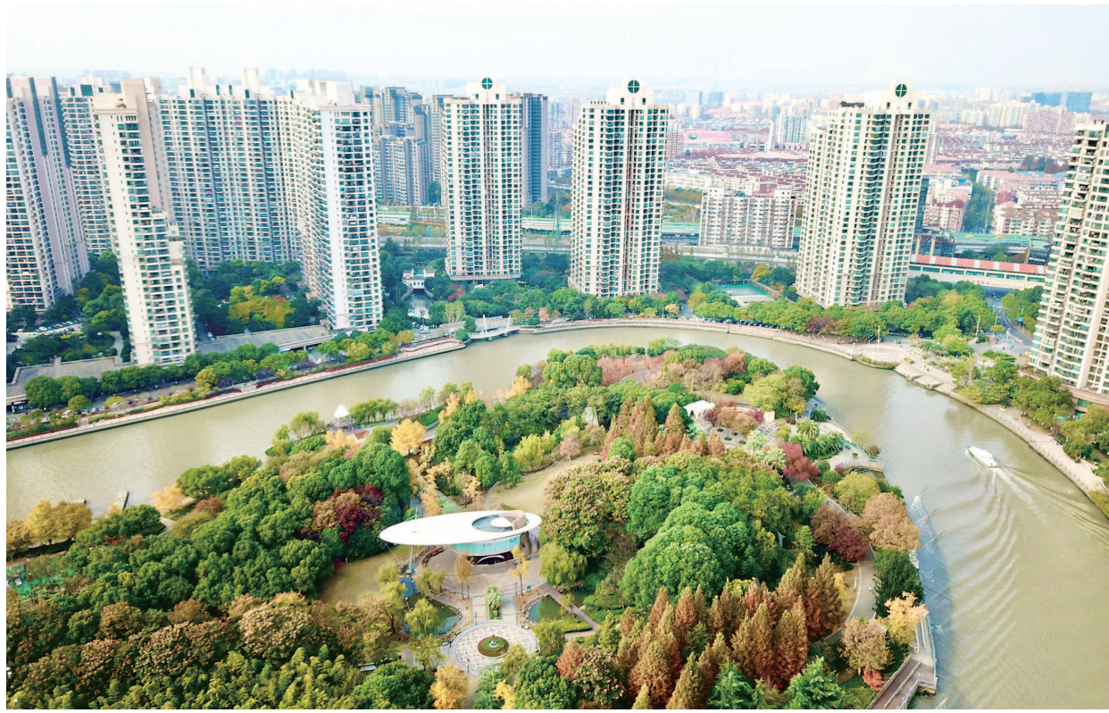
明年，苏州河普陀区段将重点提升沿线景观，推进滨水区域与沿线公园、绿地、园区连通。 本报记者 袁婧摄
