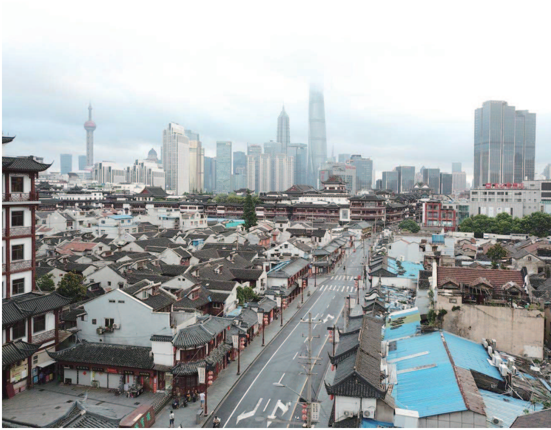
有着成片老城厢的豫园街道,位于黄浦区中心位置,也是“十三五”时期黄浦区旧改“主战场”。 本报记者 袁婧摄
