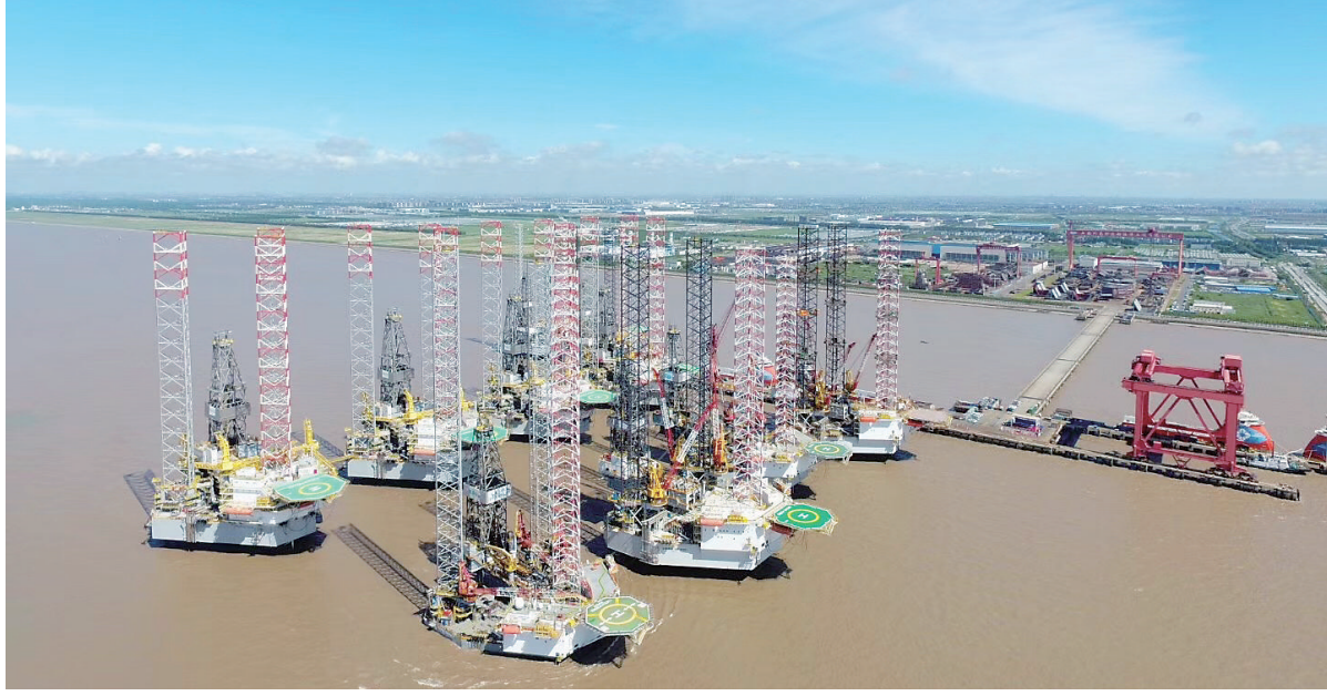
此次交付运营的钻井平台均为外高桥造船有限公司建造。（外高桥造船供图）
