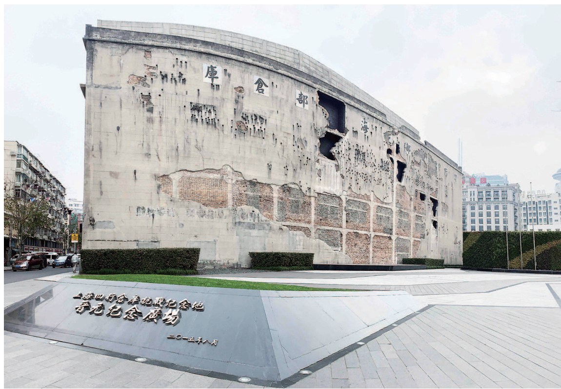
修复团队通过查找老照片和历史档案,修复了四行仓库8个主要的炮弹孔和430余个枪眼弹点。
