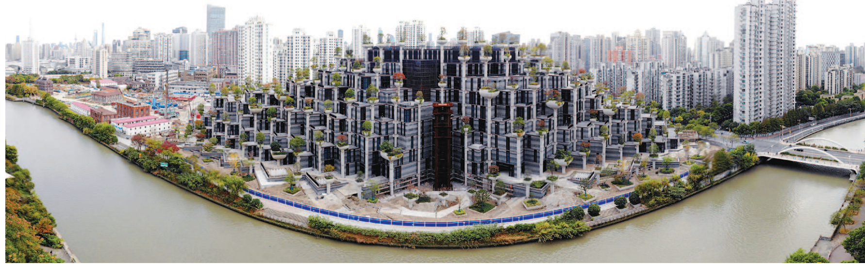
在建中的天安树城市综合体。
