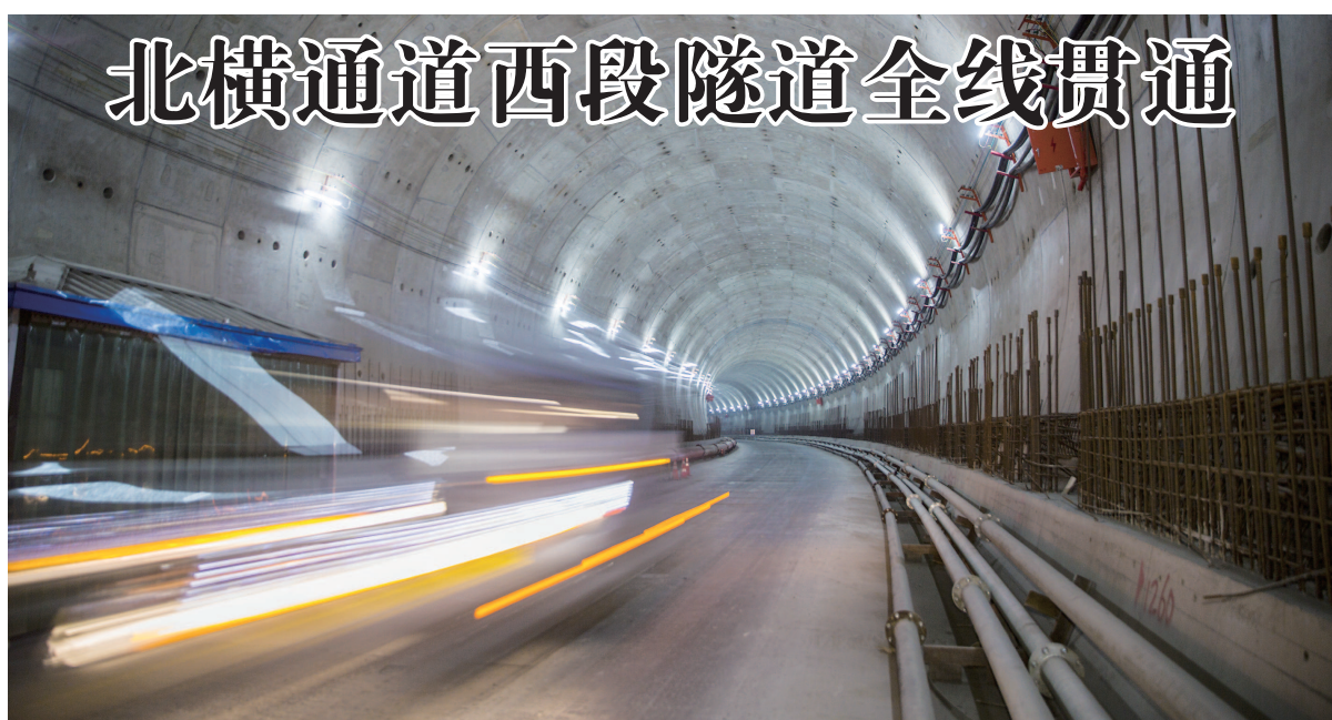
昨天,北横通道西段隧道全线贯通。
