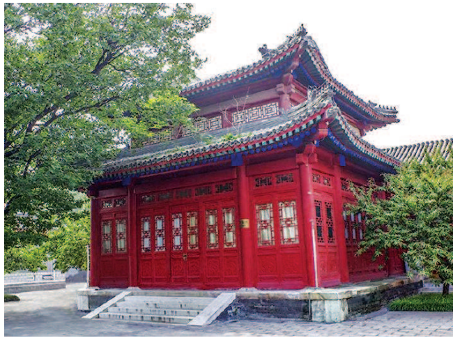
升平署是清代掌管宫廷戏曲演出活动的机构，图为升平署戏楼
