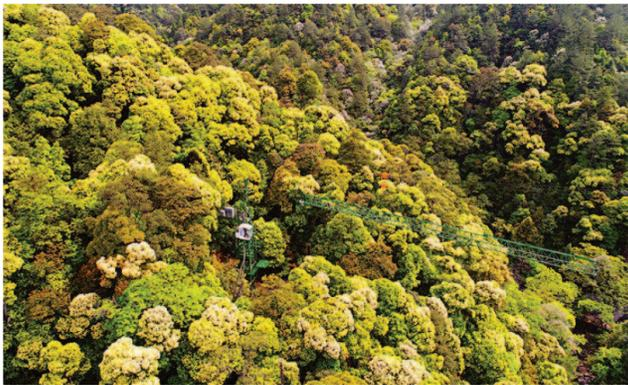
林冠层监测平台由高达60米、半径亦为60米的塔吊系统组成。
