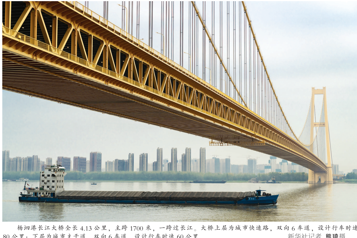
杨泗港长江大桥全长4.13公里，主跨1700米，一跨过江。大桥上层为城市快速路，双向6车道，设计行车时速80公里；下层为城市主干道，双向6车道，设计行车时速60公里。
