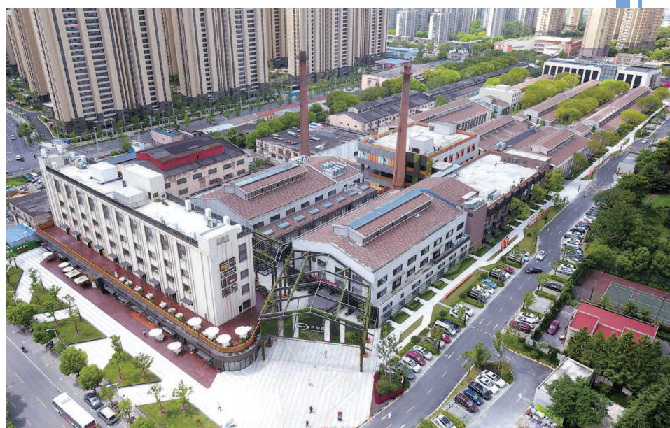
▲“三邻桥”特色体育文化园完整保留了其前身上海日硝保温瓶胆厂的工业遗迹，同时赋予旧建筑新的生命，成为周边居民休闲新街区。
