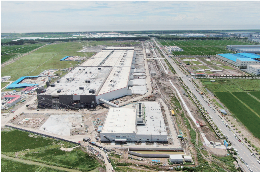
特斯拉上海工厂电力配套9月底前完工。图为航拍特斯拉上海工厂(一期)。
