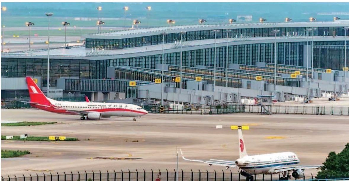
浦东国际机场卫星厅将于9月16日开航，图为卫星厅港楼机坪。（机场集团供图）
