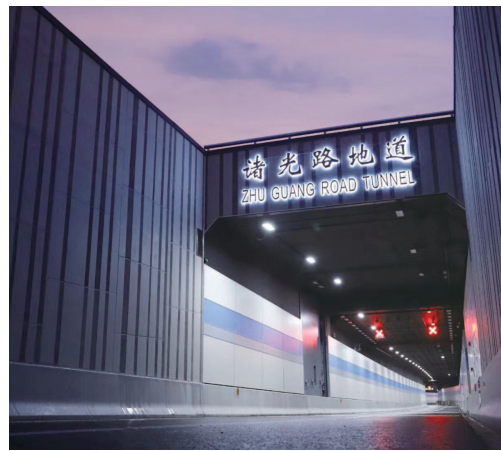
诸光路地道。（隧道股份上海隧道供图）
