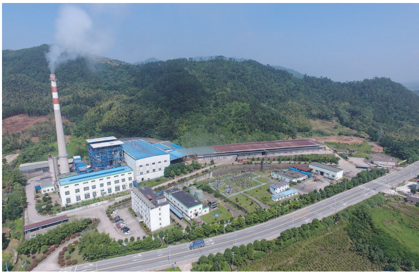
福建凯圣生物质热电厂以谷壳鸡粪混合物为原料发电大部分并入国家电网。新华社记者 林善传摄
