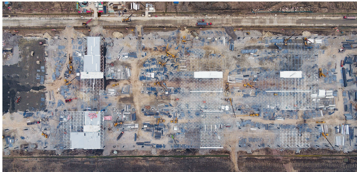
4月3日无人机拍摄的在建设中的上海特斯拉超级工厂。新华社记者 丁汀 摄
