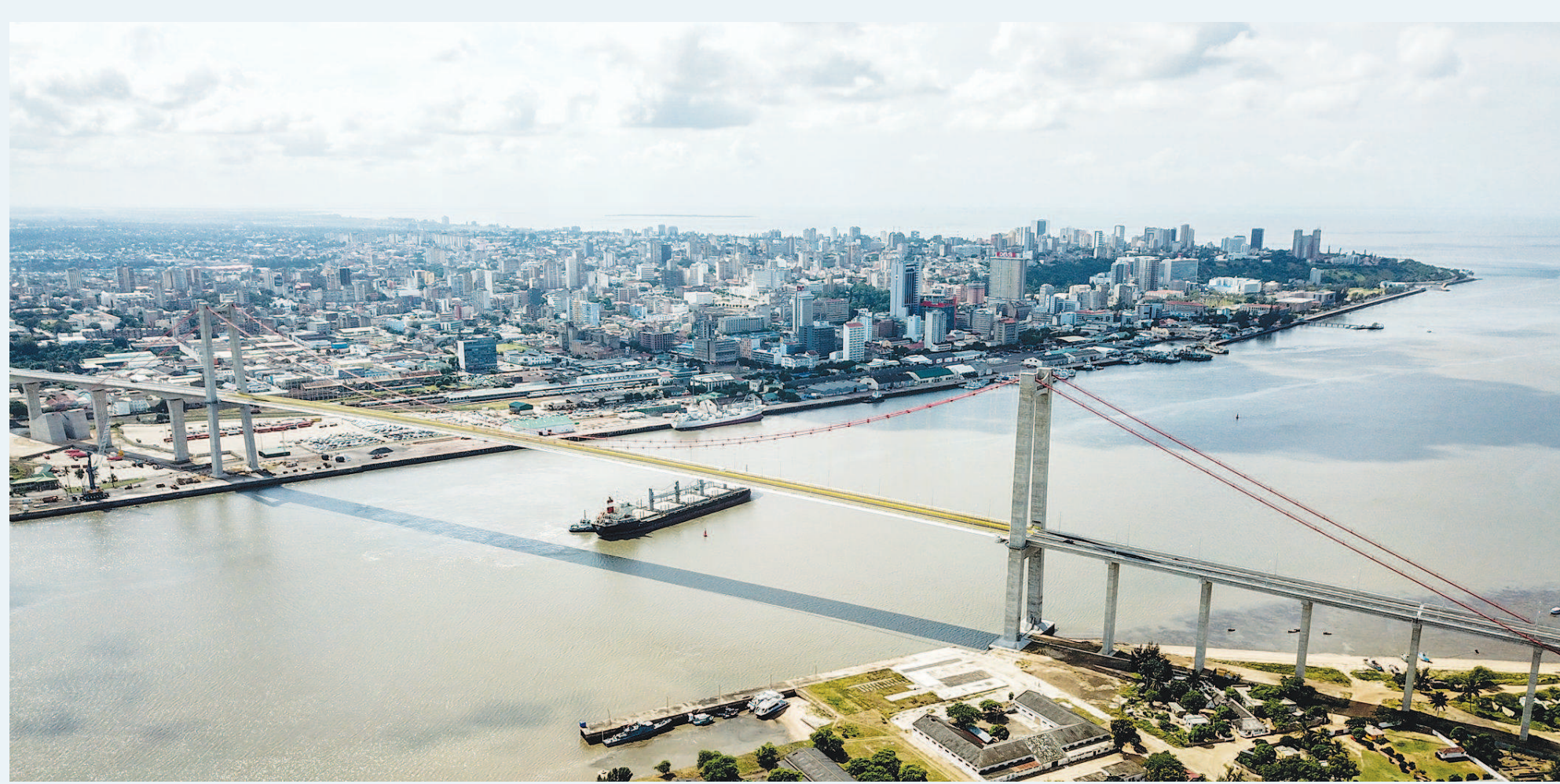
这是4月8日在莫桑比克拍摄的马普托大桥。2018年11月,由中国路桥工程有限责任公司承建的马普托大桥及连接线项目经多年建设正式通车。这座“梦想之桥”以3公里的全长和680米的主跨成为非洲第一大悬索桥,是莫桑比克总统口中的精品工程,更是民众眼中的城市新名片。
