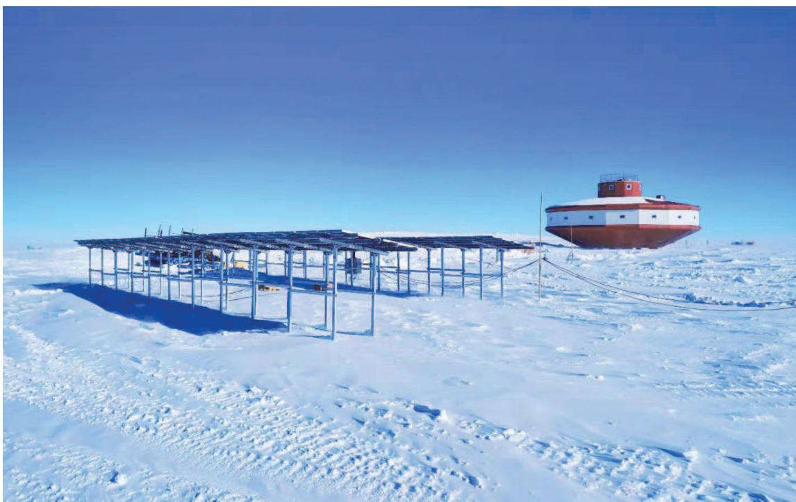
安装在南极雪地上的高效HIT微电网。(中国科学院上海微系统与信息技术研究所新能源技术中心供图)
