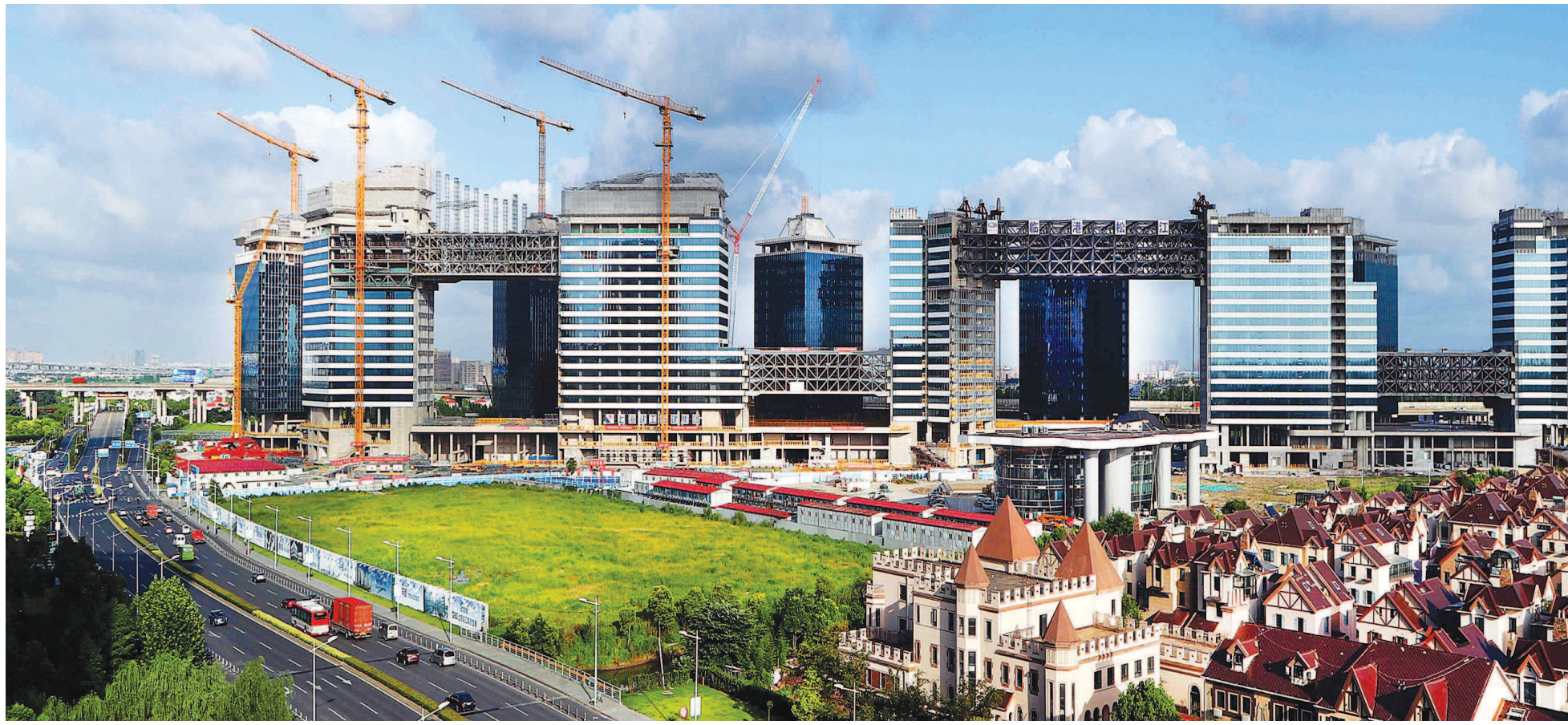
G60科创走廊正加紧建设,科创园区内大楼施工正紧锣密鼓进行。
