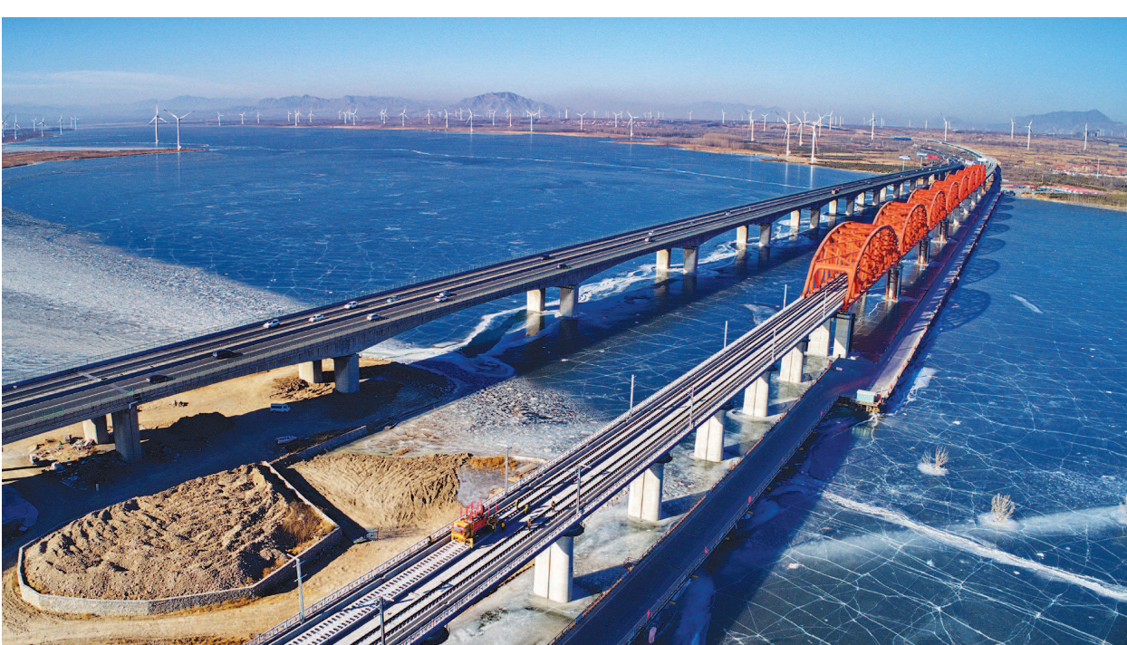
中铁三局的工人在京张高铁官厅水库特大桥进行铺轨作业（2019年1月13日无人机拍摄）。 新华社发
