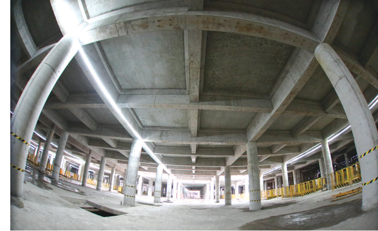
在大型地下空间大量运用预制装配式技术,白龙港污水处理厂提标改造工程是全国首例。 本报记者 叶辰亮摄
