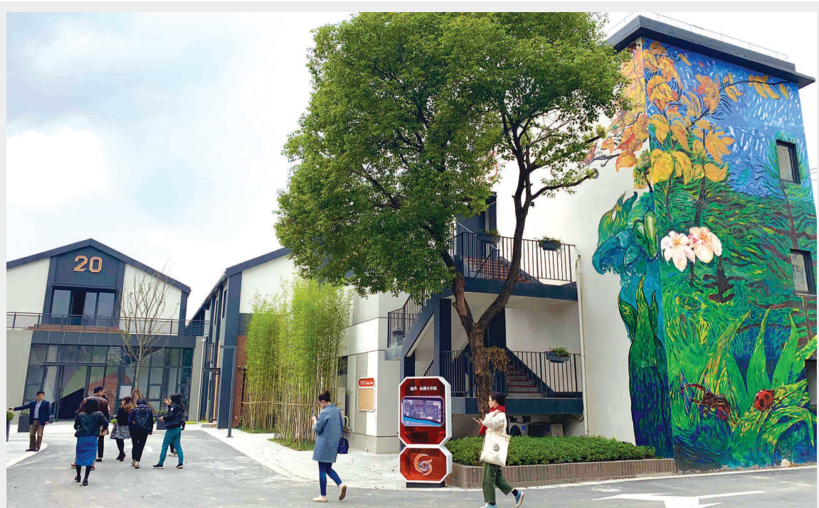
日前，以“城市更新，文创生活”为主题的“2018上海光华人文论坛”，在“越界·丝腾光华”创意产业园内举行。这个产业园，由闵行区颛桥镇光华路上的一片老粮库仓储楼改建而成。
