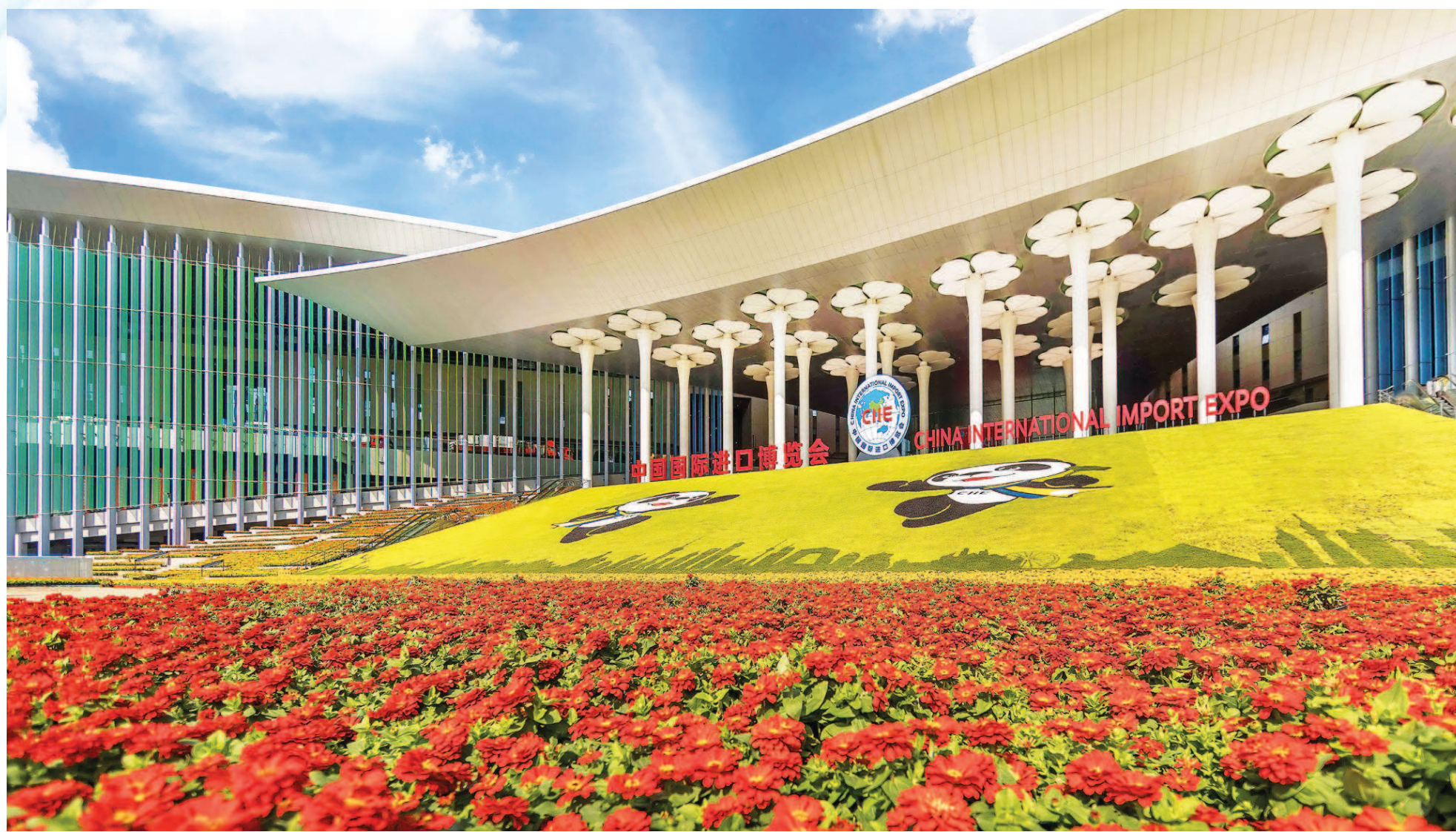
▲国家会展中心(上海)南广场上的绿化景观工程已完工,呈现一派喜庆气氛。
