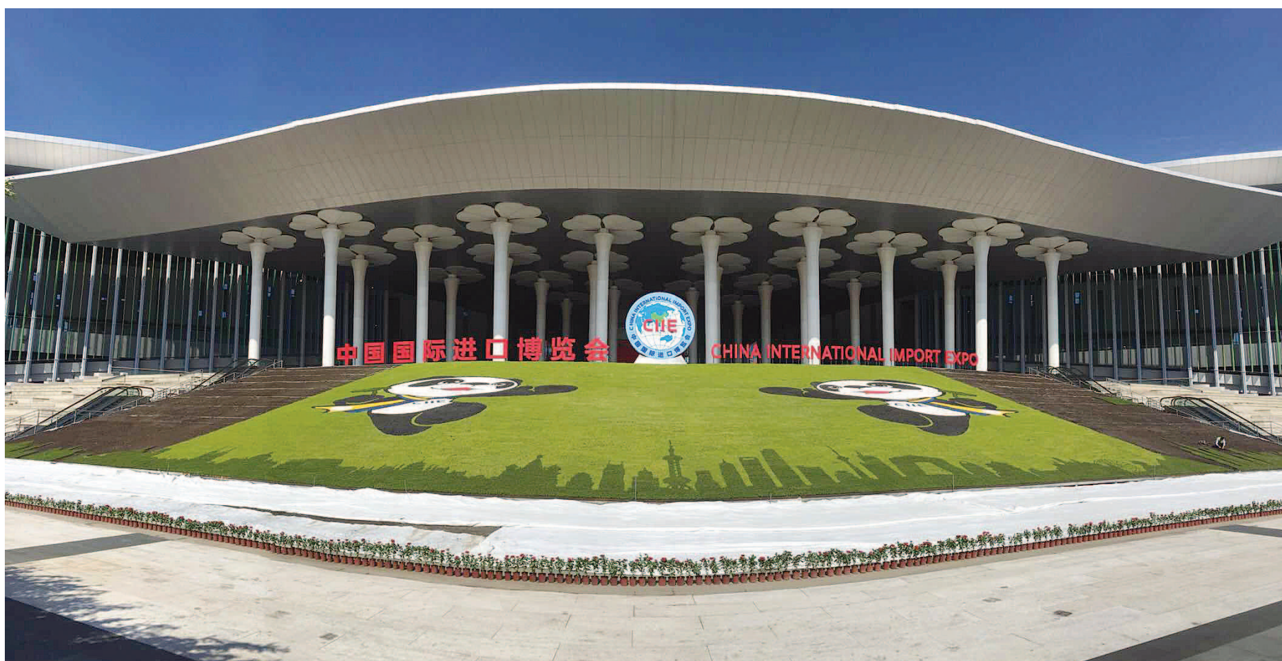
国家会展中心(上海)1号入口处景观绿化布置和地面施工进入收尾阶段。
