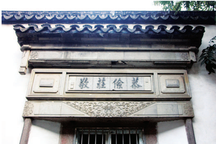
▲顾廷龙故居的堂楼与大厅间有一座完整的砖雕门楼，上面是“四朝元老”潘世恩题写的字牌“恭俭庄敬”。
