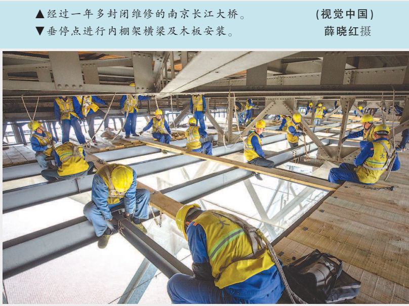
▲经过一年多封闭维修的南京长江大桥。（视觉中国） ▼垂停点进行内棚架横梁及木板安装。薛晓红摄
