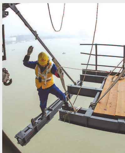
工人们正在吊装外棚架钢结构，脚下就是滚滚长江。刘曙光摄
