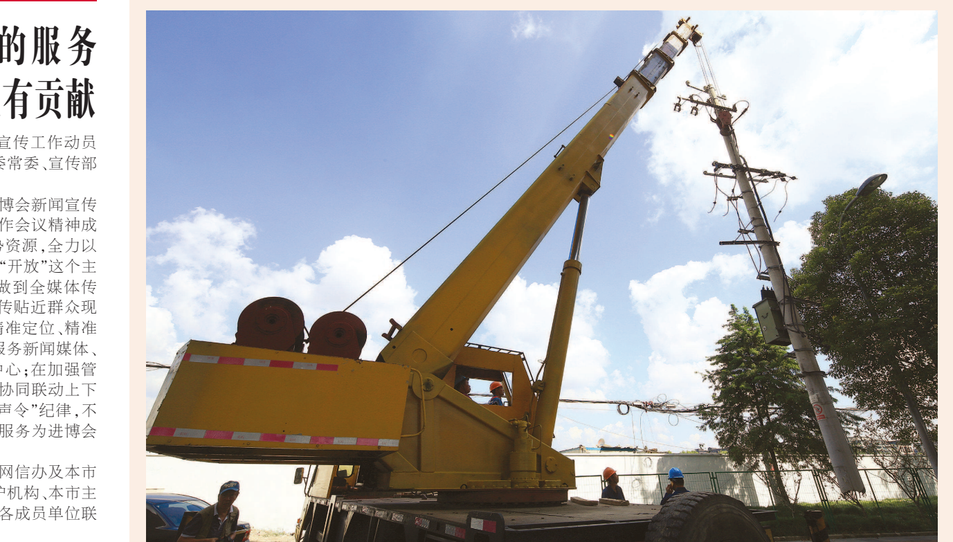
这几日，国家会展中心（上海）周边重点区域又有九条道路电力架空线陆续入地，图为工人在拔杆。
