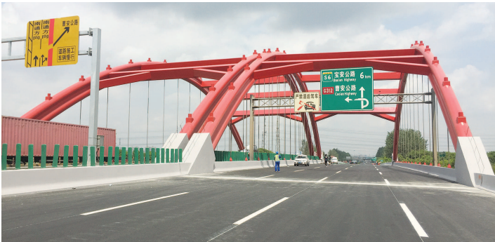
修缮一新的G15嘉金高速北段即将通车。（隧道股份路桥集团供图）
