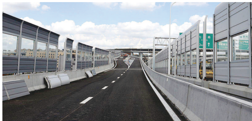
S26公路路面铺装工程进入最后收尾阶段。 本报记者 王嘉旖摄
