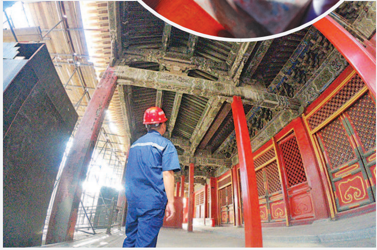
养心殿内搭建起脚手架，工匠们已准备就绪。
