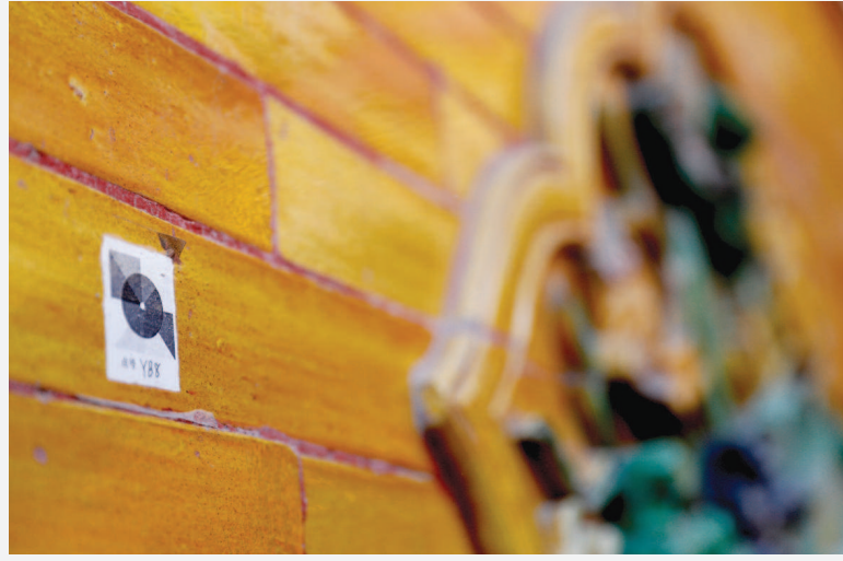
殿内随处可见各种标记的测量、施工点位，修缮工程正科学有序地进行。
