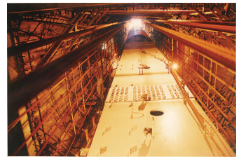
东方明珠 116 米,450 吨钢天线桅杆整体提升
