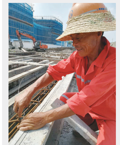
整个工程中,最辛苦的数钢筋工和模板工,项目中有三座桥梁施工,浇筑钢筋混凝土时,要确保在混凝土干掉前把扎钢筋、做模板的活跟着工程进度干完,一般两三个小时活都不能停,大的结构有时还需要连续作战五六个小时。 图为浇筑混凝土前,工人在烈日下徒手扎钢筋。 周振摄
