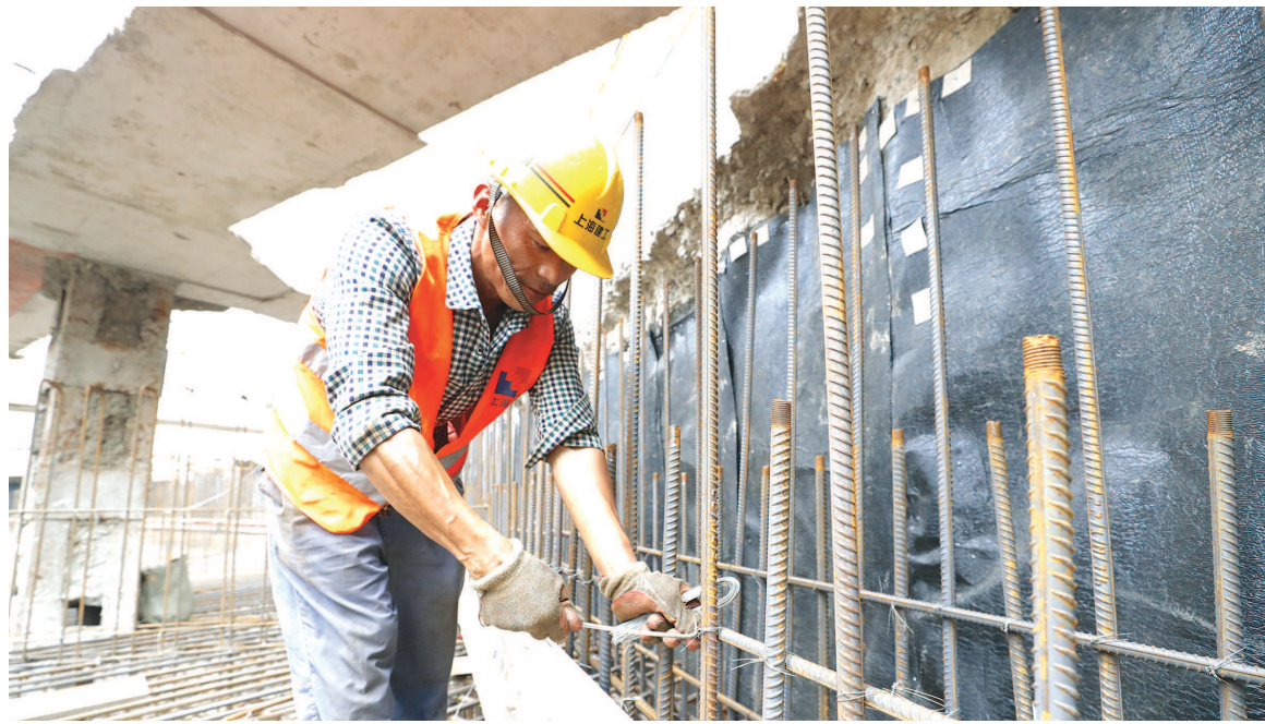
周勇技巧娴熟，他的手指可以灵活地在横竖相间的钢筋上来回穿梭，仿佛在琴键上起舞。随着气温升高，这些螺纹钢逐渐变得烫手。为了避免被烫手的钢筋烫伤，钢筋工人们会戴上厚厚的手套。图为周勇正在高温下绑扎钢筋。本报记者 袁婧摄
