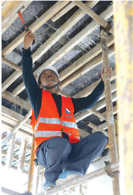
烈日下，胡建光在上海建工工地加固木结构。本报记者 袁婧摄
