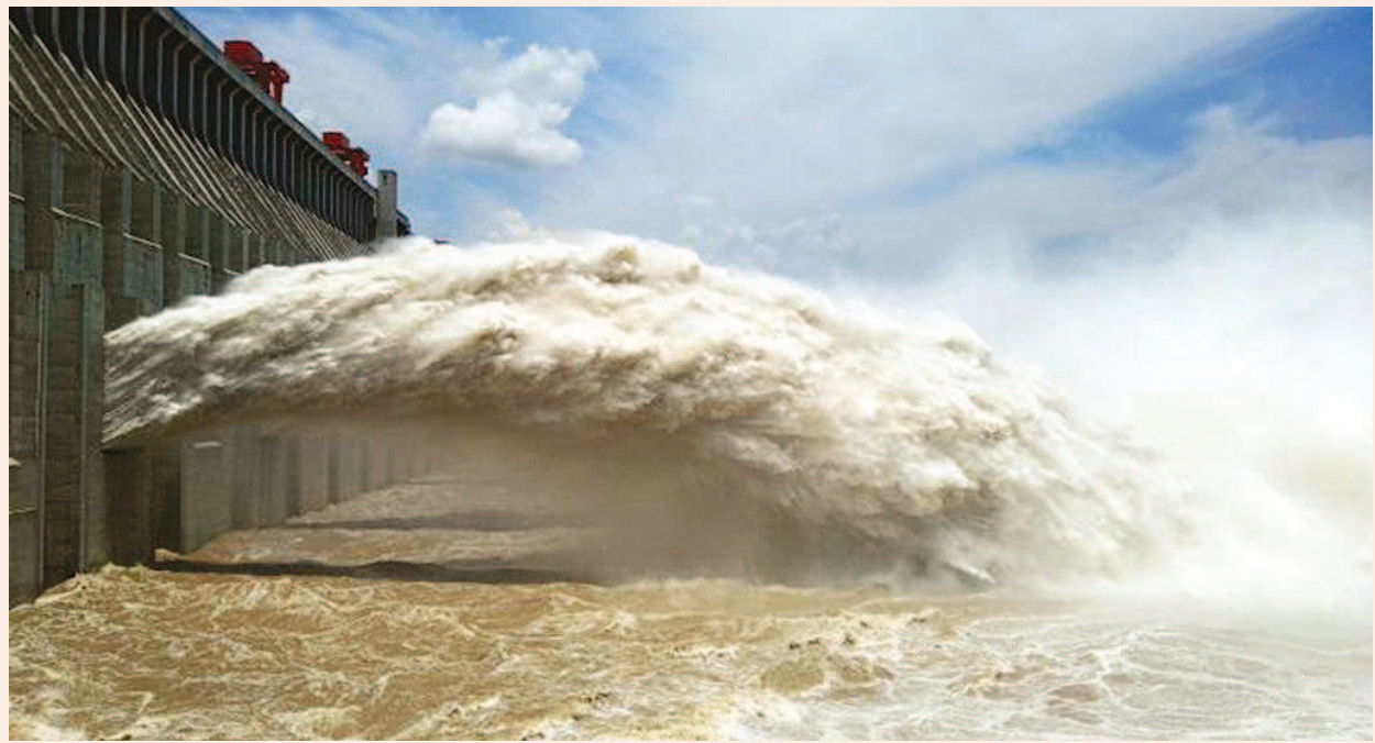
三峡大坝开启泄洪深孔加大下泄流量。
