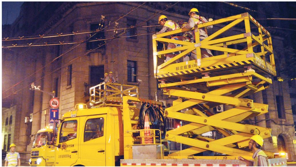
工人们在对南京东路、中山东一路口上空的公交20路外滩段架空线进行整体拆除。
