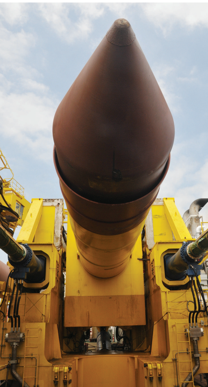
全长55米的主钢桩，尖头实心，重185吨。
