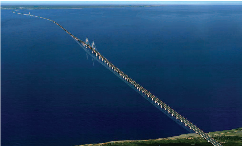
杭州湾跨海大桥建成后,长三角地区的来往更为便利。
