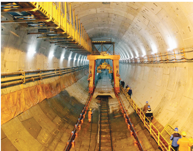
诸光路通道新建工程施工现场。（隧道股份供图）
