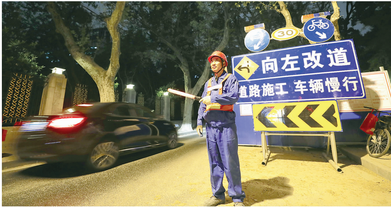
为了减少夜间施工对交通的影响,确保路面行驶安全,施工方特意安排专人进行交通疏导。
