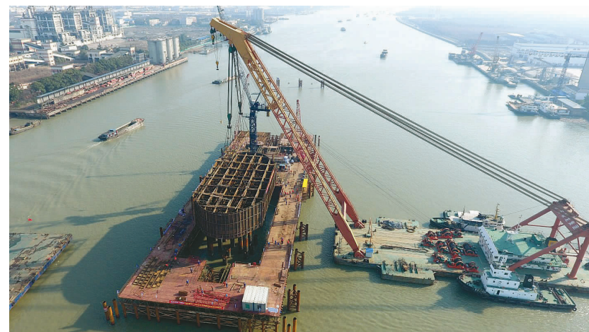
昆阳路越江工程黄浦江主墩钢吊箱完成第一次吊放。上海城投集团供图
