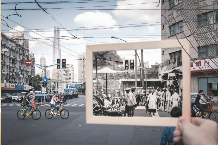
老西门(仪凤门),位于今复兴东路(西段)中华路口。
