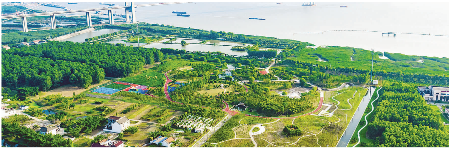
江苏泰州在滨江区域整治厂房屋,生态修复初见成效。
