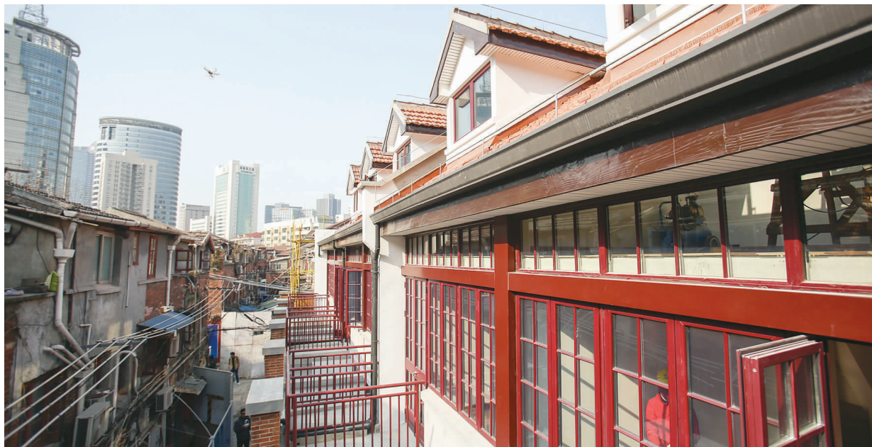
试点改造后的房屋与暂未改造的房屋形成鲜明对比。
