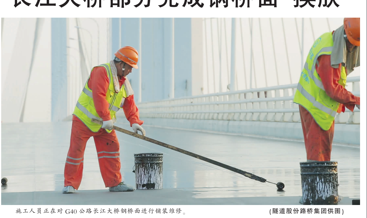
施工人员正在对G40公路长江大桥钢桥面进行铺装维修。(隧道股份路桥集团供图)
